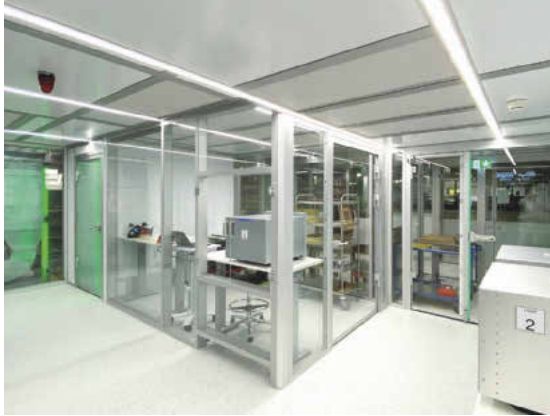
Vollverglaster ISO5-Reinraum Clean Cell 4.0 von Schilling Engineering für die neue Sputteranlage
